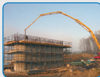
Ponte sul fiume Po - Revere (Mn)
